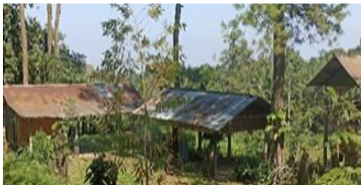
Gambar 6. Warung Makan yang Tidak digunakan (Dokumentasi Peneliti, 2024)
